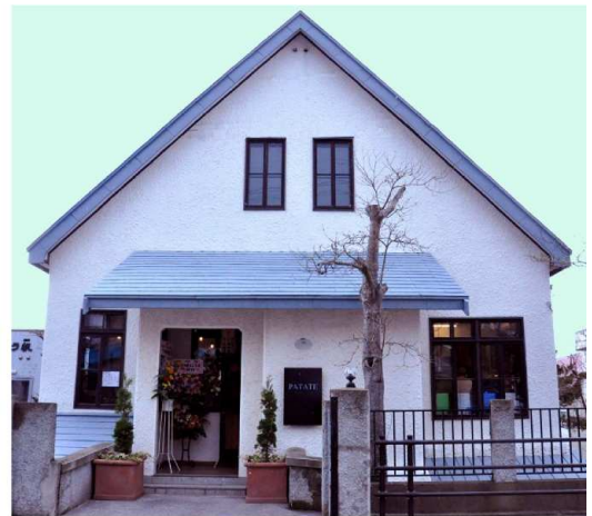
函館パターテの外観
